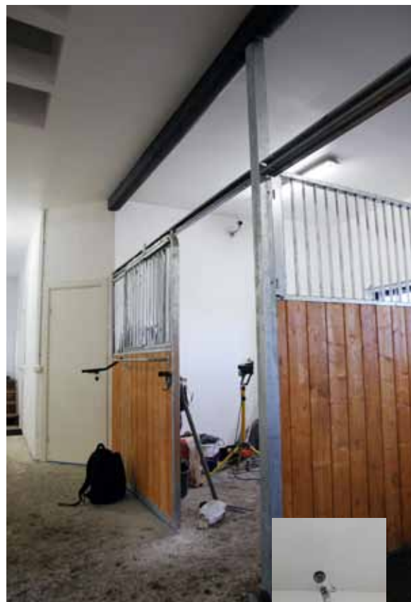
Mats Glas har ett förflutet som nätverkstekniker och kunde montera alla kablar själv. Kamerorna vakar både ute och inne i stallet.
